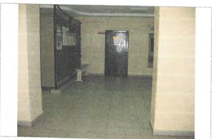
Фото №14 – Вход в здание (холл)
