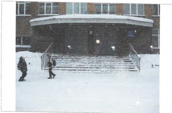
Фото №7 – Вход в здание (лестница)
