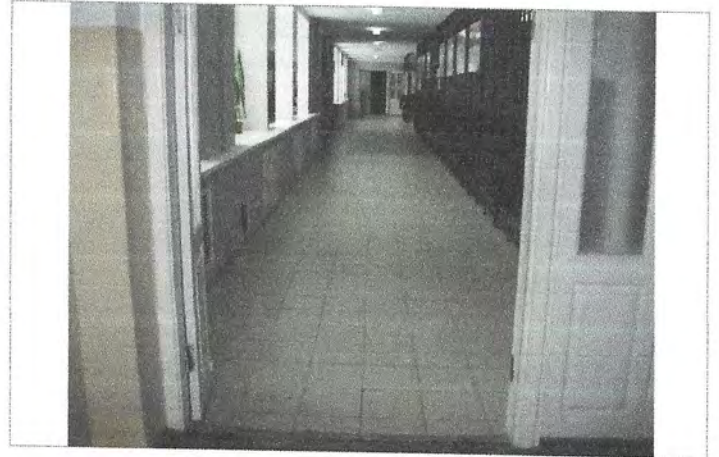
Фото №16 – Пути движения внутри здания (коридор)
