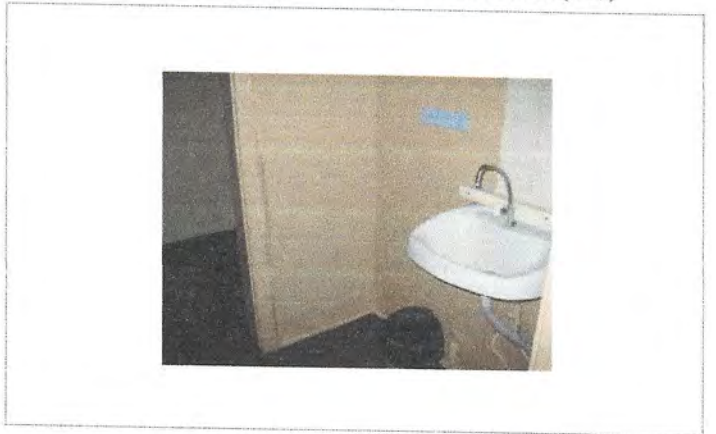
Фото №38 – Санитарно-гигиенические помещения
