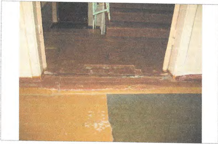
Фото №23 – Пути движения внутри здания (Порог к запасному выходу)
