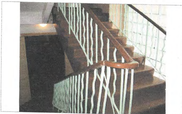
Фото №21 – Пути движения внутри здания (лестница 3)
