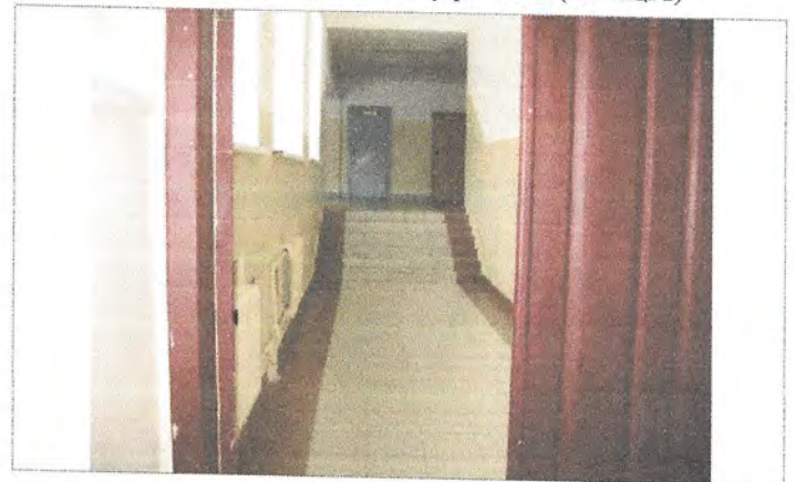
Фото №20 – Пути движения внутри здания (коридор)
