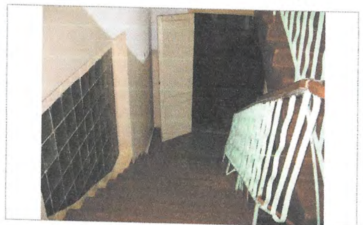
Фото №22 – Пути движения внутри здания (лестница 4)
