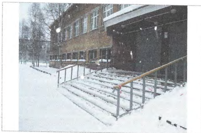
Фото №8 – Вход в здание (лестница)
