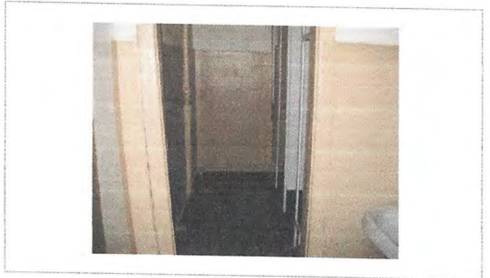
Фото №36 – Санитарно-гигиенические помещения (вход)
