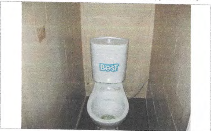
Фото №37 – Санитарно-гигиенические помещения
