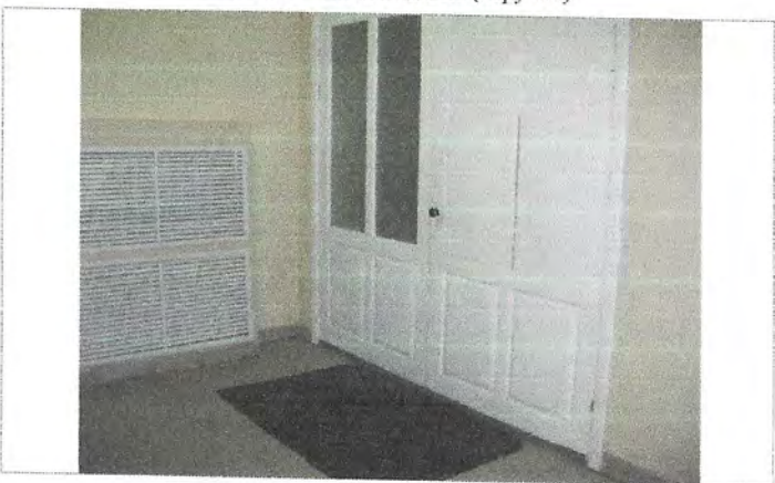
Фото №11 – Вход в здание (тамбур)
