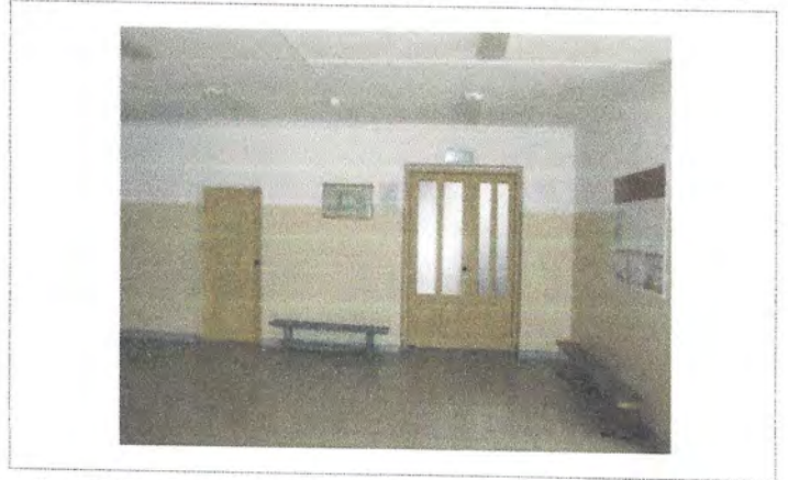
Фото №26 – Пути движения внутри здания (Запасной выход со 2 этажа)
