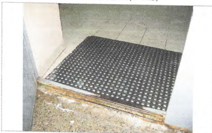
Фото №10 – Вход в здание (порог)
