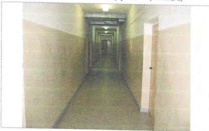
Фото №19 – Пути движения внутри здания (коридор)
