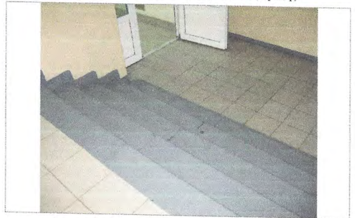
Фото №18 – Пути движения внутри здания (лестница 2)
